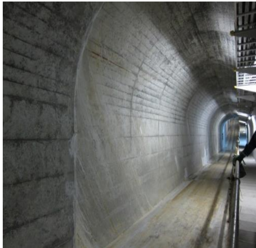
施工後：止水状況
