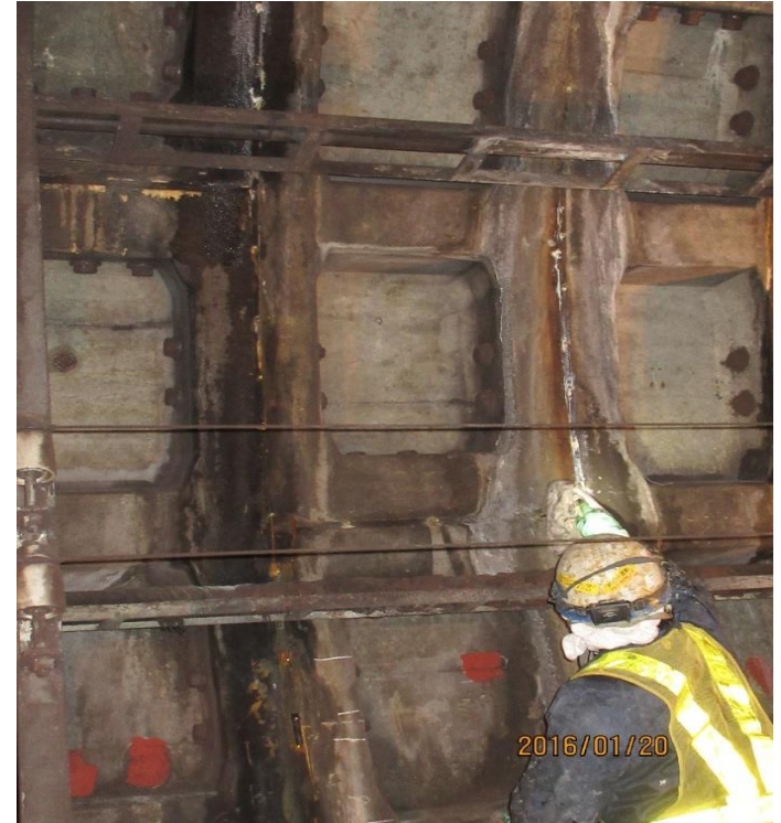
施工後；止水状況
