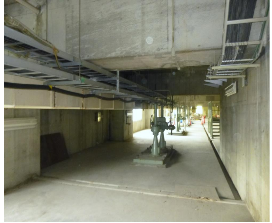
施工後：止水状況
