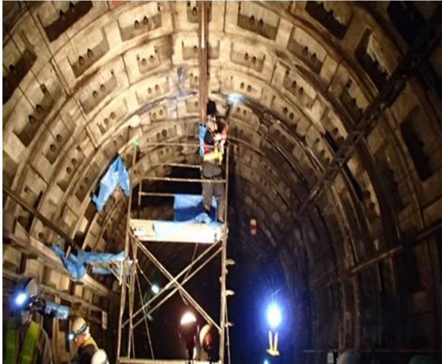
施工中：注入施工中
