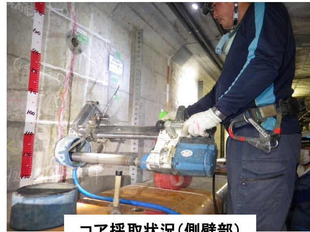
コア採取状況(側壁部)
