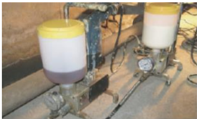
注入状況写真
