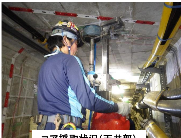
コア採取状況(天井部)
