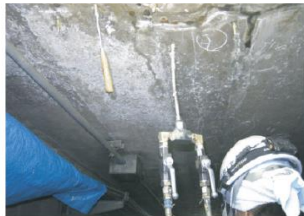
注入状況写真
