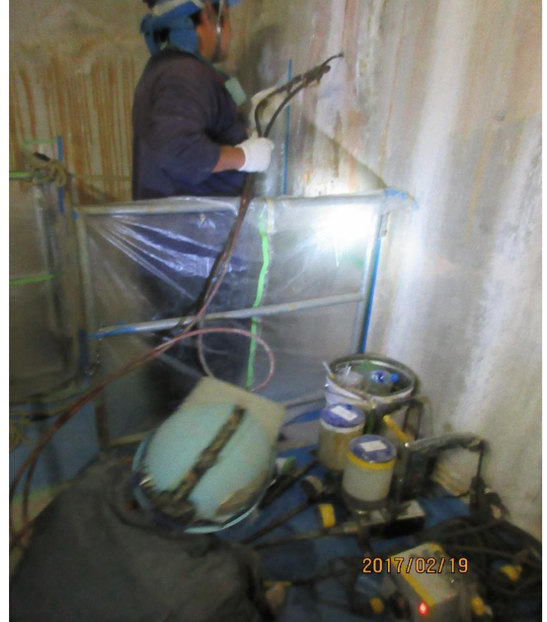
施工中：止水施工中
