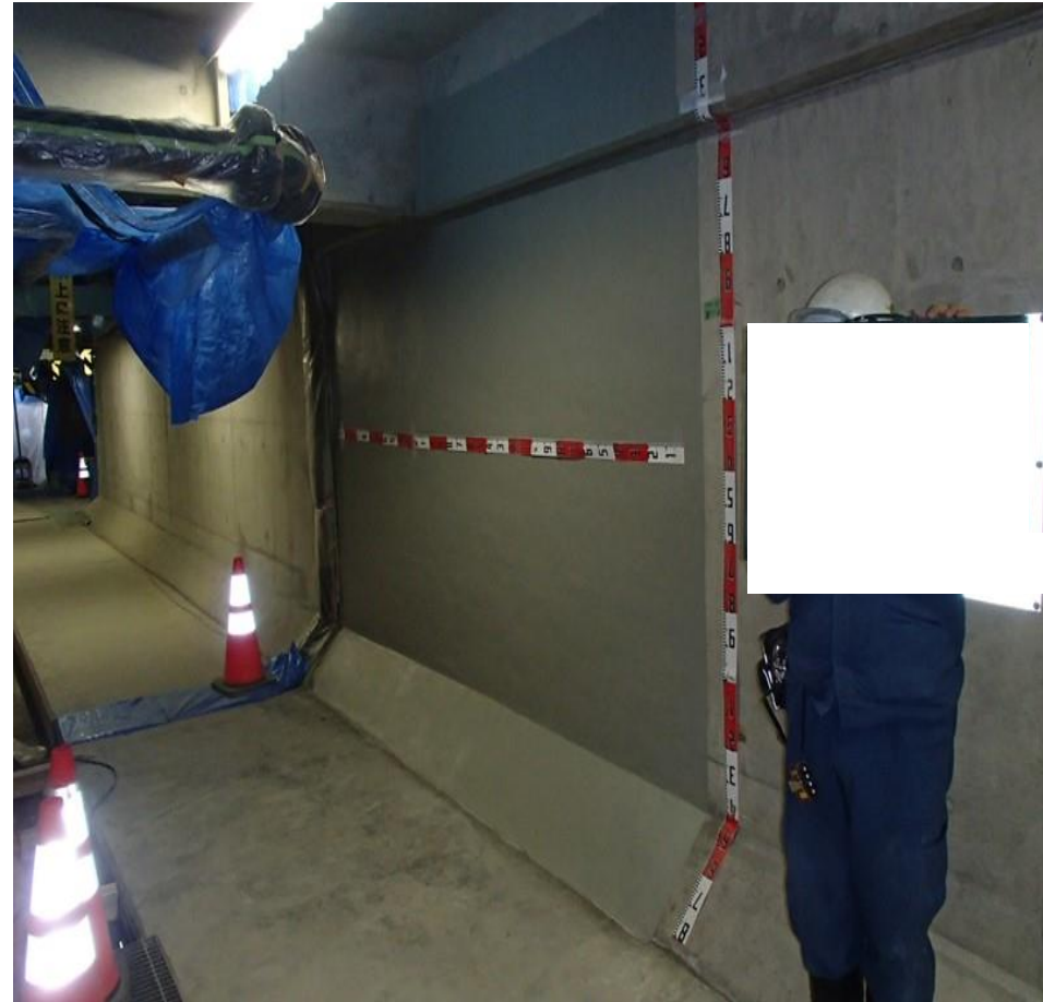
施工後：止水状況
