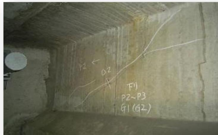
せん断ひび割れが生じたPCT桁
