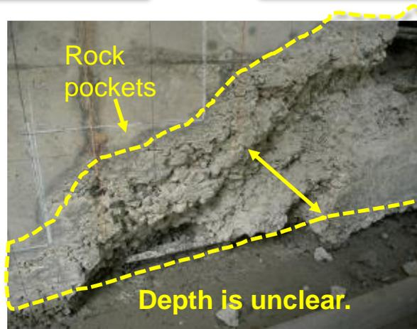
内部欠陥を非破壊検査で調査する必要がある
