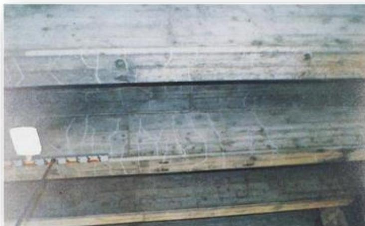
過大な荷重载荷により生じた曲げひび割れ
