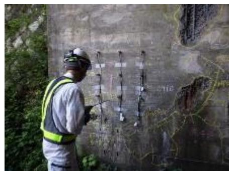
図- ドリル削孔状況
