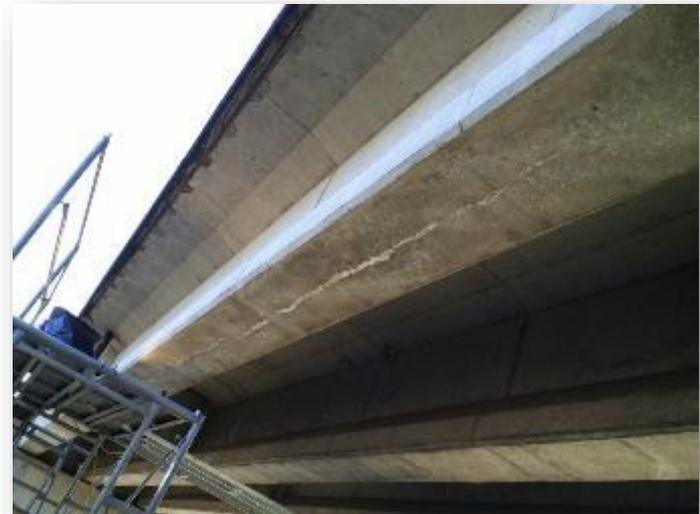
ポストテンション方式T桁の下フランジに生じたひび割れの事例
