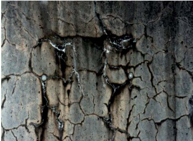
コンクリート表面の変状
