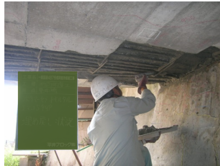
剥離部を部分断面修復
