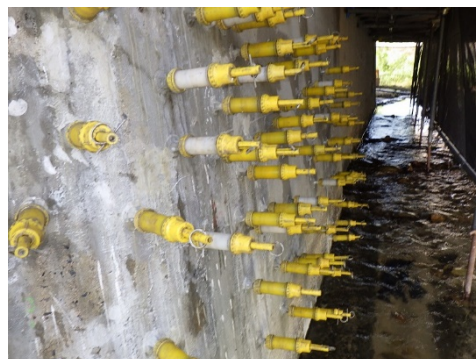
ひび割れ注入工
