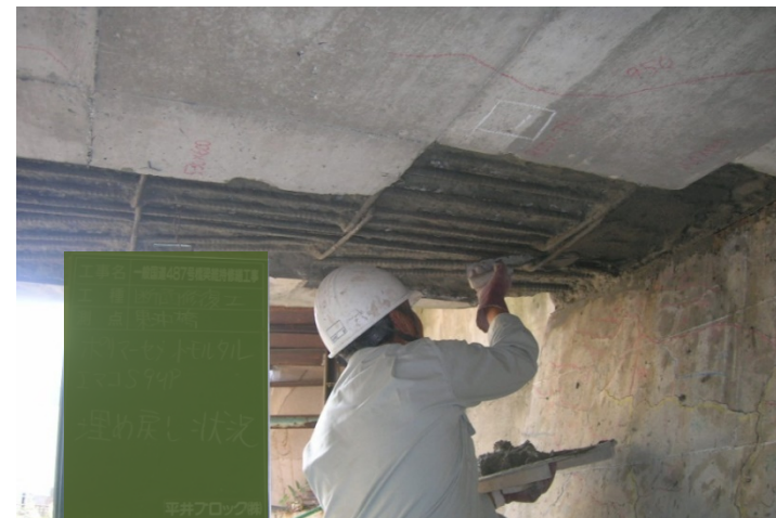
部分断面修復工
