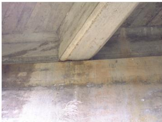
潜伏期、進展期の外観
