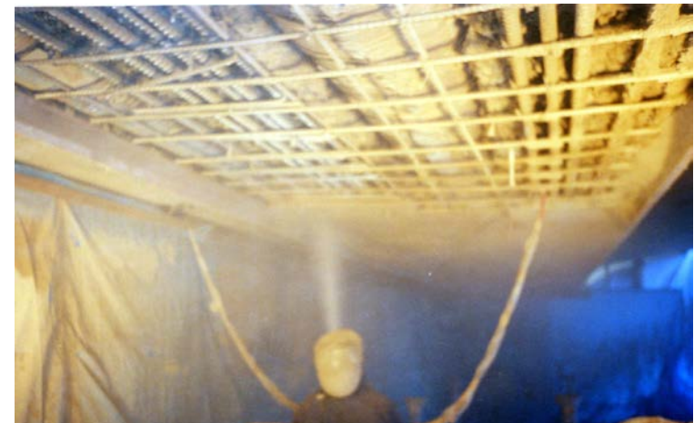
全断面修復工法
