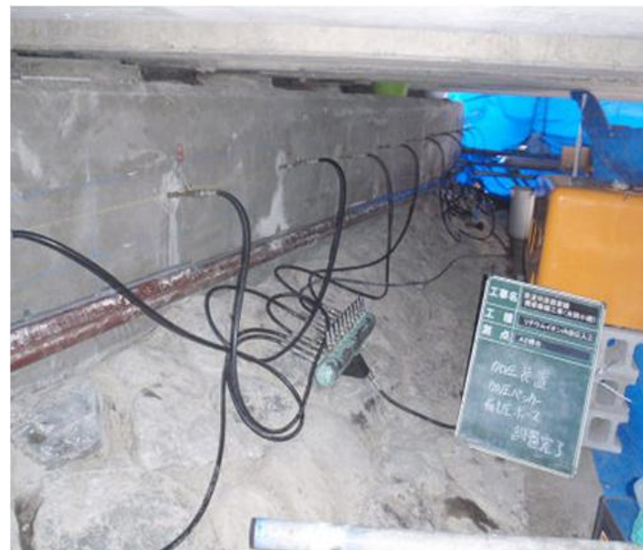
亜硝酸リチウム内部圧入工法
