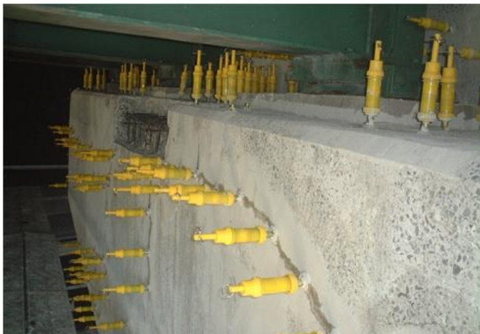
ひび割れ注入工
