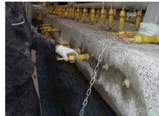
浸透拡散型亜硝酸リチウムの先行注入により鉄筋の不動態皮膜を再生
