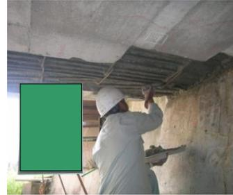
亜硝酸リチウム系表面含浸材の塗布および同材含有のポリマーセメントペースト塗布により鉄筋の不動態皮膜を再生
