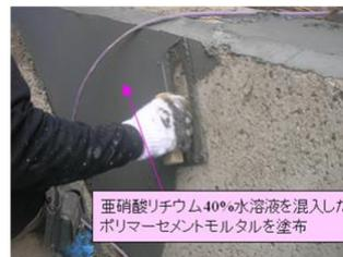
亜硝酸リチウム40%水溶液を混入した
