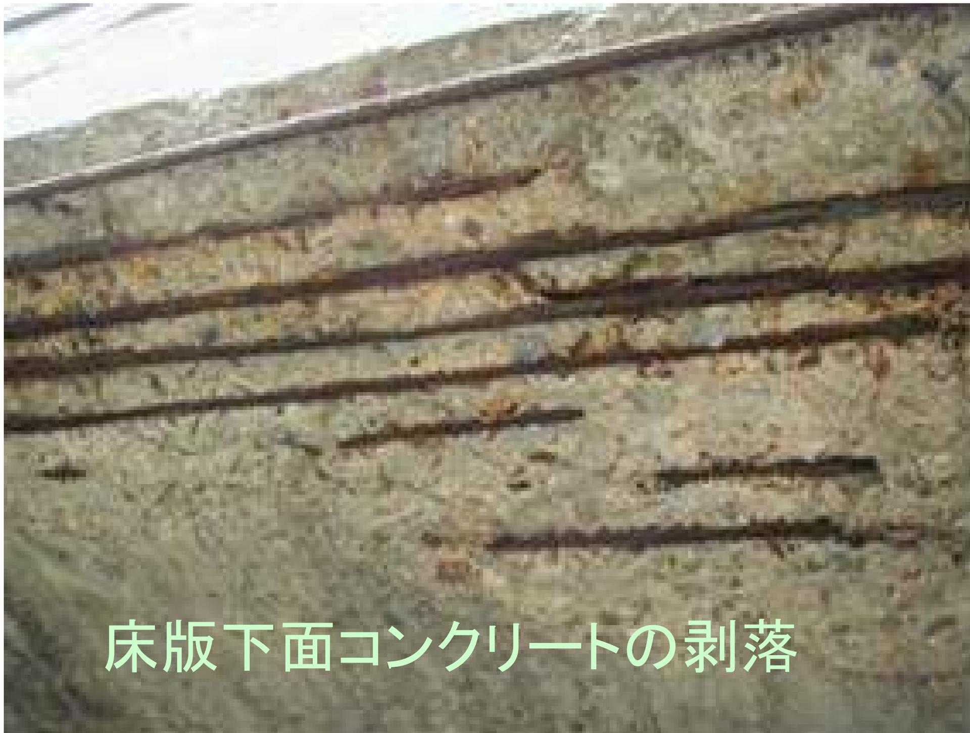
床版下面コンクリートの剥落
