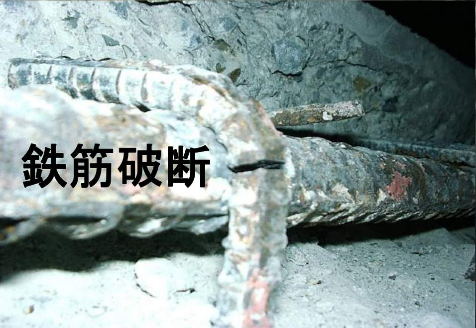
**鉄筋破断**
