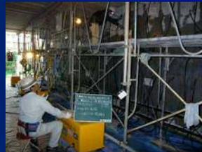
亜硝酸リチウム内部圧入工施工状況
