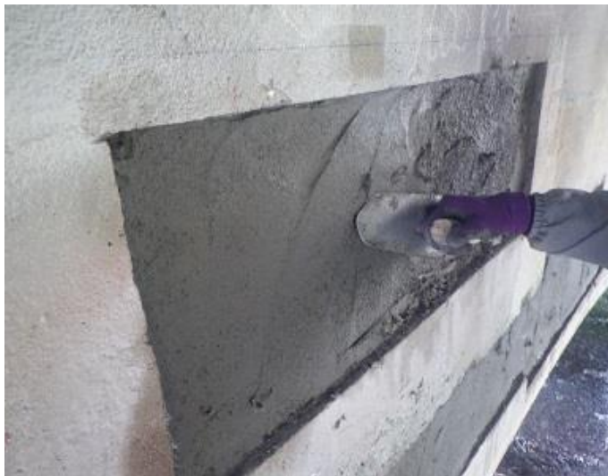
浮き、剥離部にリハビリ断面修復工法
