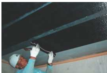
▲炭素繊維シート貼り付け状況
