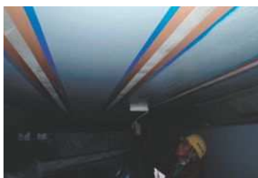
▲表面保護材塗布状況
