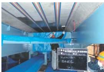
▲プライマー塗布状況
