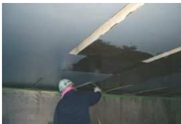
▲不陸修正状況
