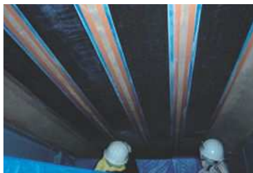
▲含浸材（上塗り）状況
