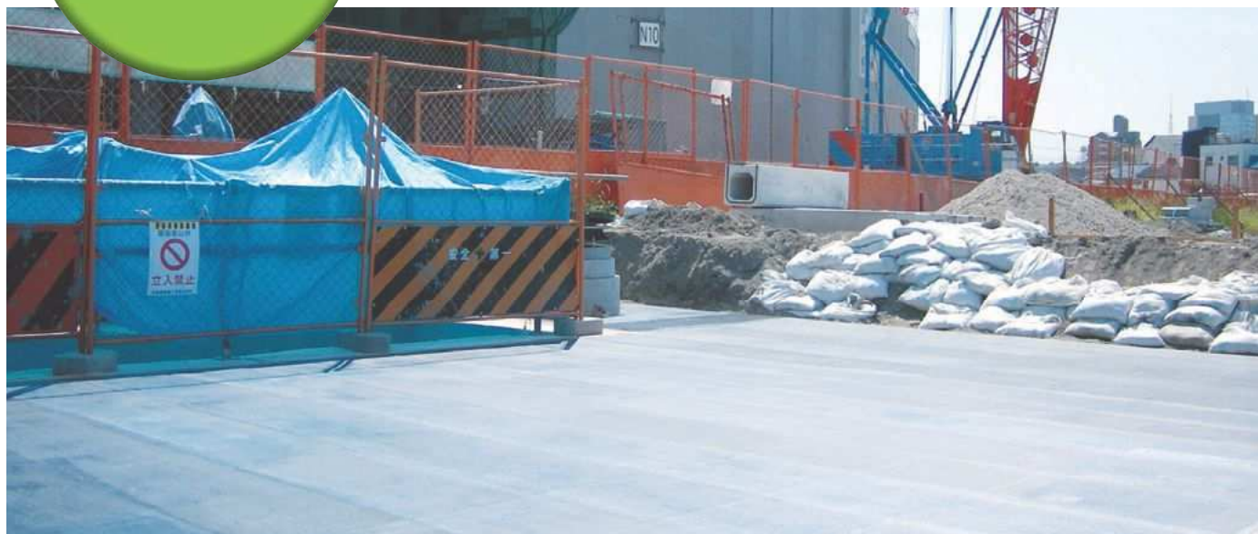
▲コンクリート構造物上部への施工状況
