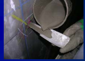
⑨ 圧入孔充填工
