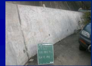
⑦ひび割れ注入工完了
