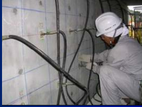
⑥ 圧入装置の設置
