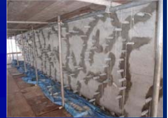
自動低圧注入器(ゴム圧タイプ)
