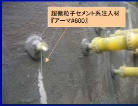
⑤本注入(超微粒子セメント系注入材)
