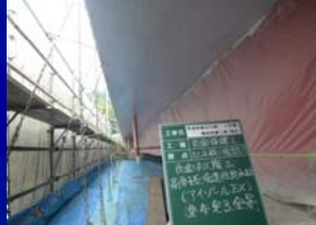
⑪施工完了
