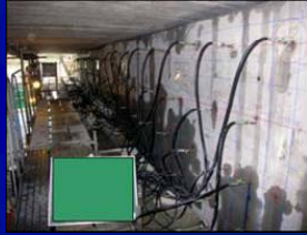
⑦ 試験加圧注入工
