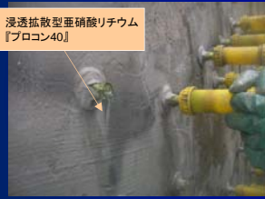
④先行注入(亜硝酸リチウム水溶液)
