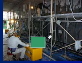
⑧ 本加圧注入工
