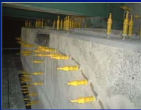
自動低圧注入器による注入状況
