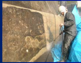
②下地処理(高圧洗浄)
