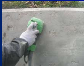
⑥注入器撤去
