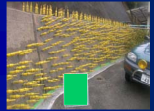
③自動低圧注入器の設置
