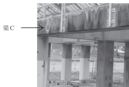
写真 5 梁 C の 19 年目のコア採取箇所
