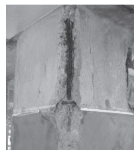
写真 3 柱 A の鉄筋外観
