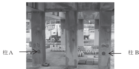
写真 4 柱 A、柱 B の 19 年目のコア採取箇所
