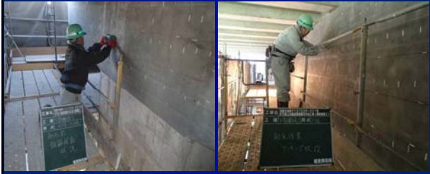
⑦鉄筋探査工
