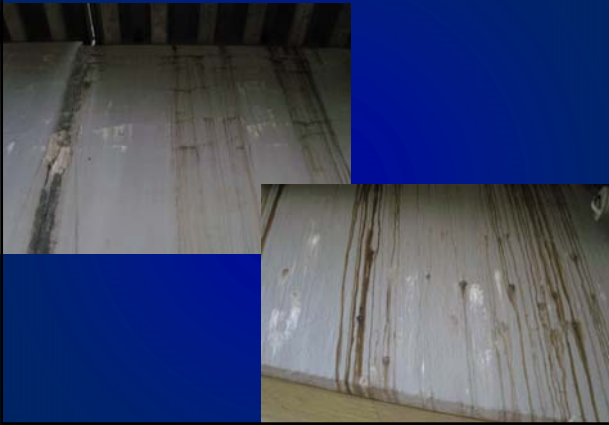
【山内高架橋の劣化状況】
