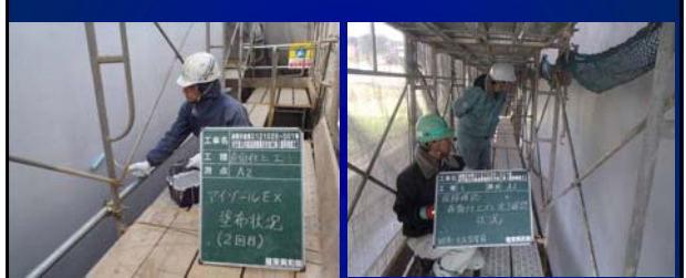
⑮表面仕上げ工
