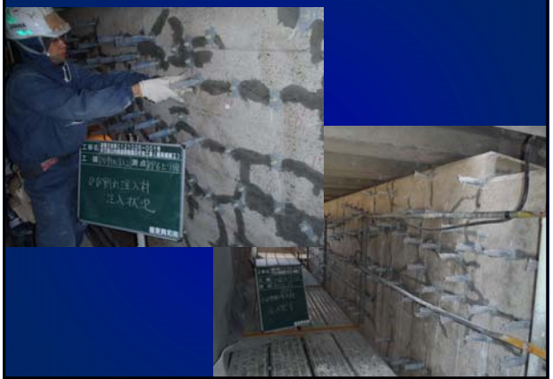
【山内高架橋の劣化状況（塗膜除去後）】
