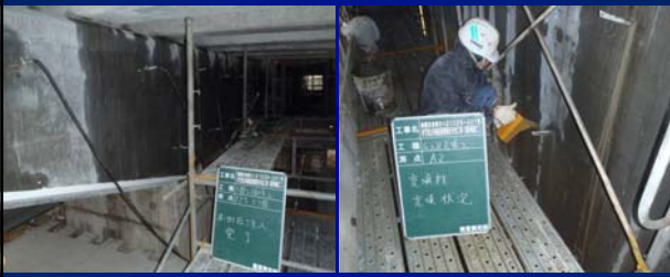
⑬試験加圧注入工 および 本加圧注入工
