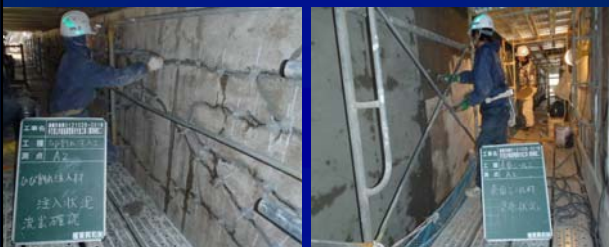
⑤ひび割れ注入工
