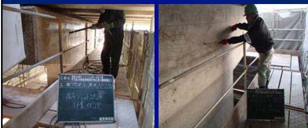
③下地処理工
