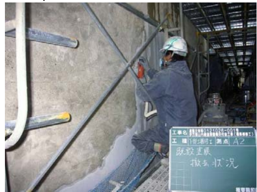
② 既設塗膜撤去工
