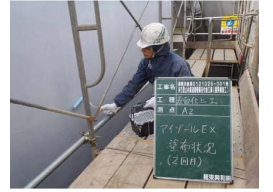
⑭ 表面仕上げ工
