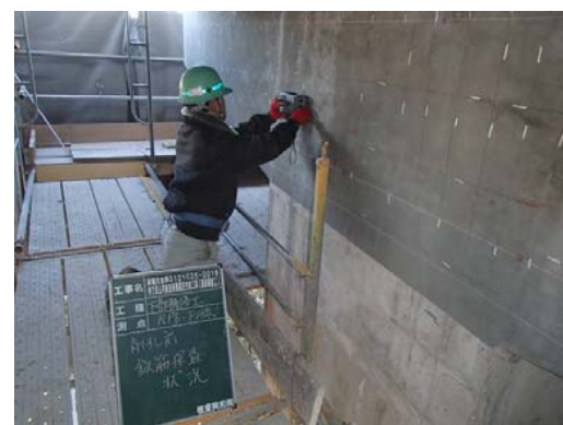
⑥ 鉄筋探査工
