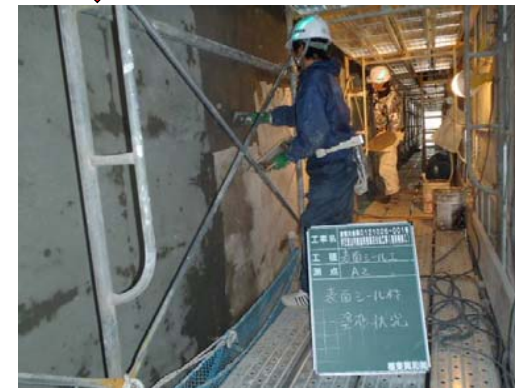
⑤ 表面シール工
