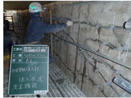
⑤ ひび割れ注入工
