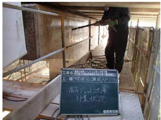
③ 下地処理工
