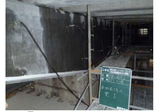
⑪⑫ 加圧注入工
