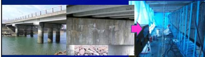
外観変状：橋脚、橋台に亀甲状ひび割れ。一部のひび割れから錆汁。
