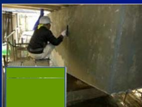
・コンクリート表面を有機系、無機系の材料にて被覆することにより、コンクリート表面からの劣化因子(塩化物イオン、水、酸素)の侵入を防ぐ
