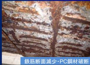
鉄筋断面減少・PC鋼材破断
