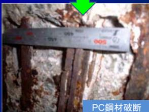
PC鋼材破断
