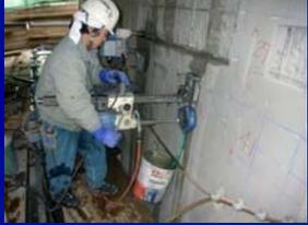
圧入孔として、φ20mmのコア削孔を行う。本橋台では削孔ピッチを500mm間隔とした。
