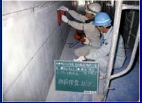
圧入孔の削孔時に鉄筋を損傷させることのないよう、鉄筋探査を行う
