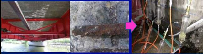
外観変状： 鉄筋に沿ったひび割れ。一部には錆汁、浮きはく離も見られる。
