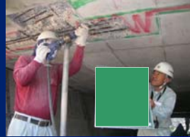
②コンクリートはつり
