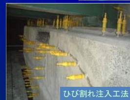
ひび割れ注入工法
