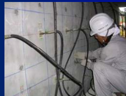
⑥圧入装置の設置
