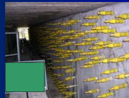
②表面漏出防止(ひび割れ注入)
