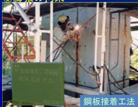
鋼板接着工法
