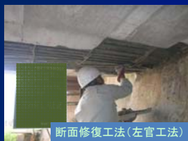
断面修復工法(左官工法)
