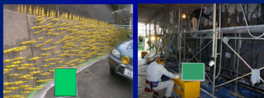
ひび割れ注入工
