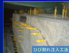
ひび割れ注入工法
