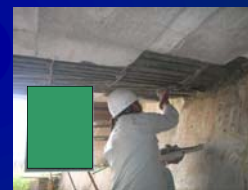
亜硝酸リチウム含有モルタル
