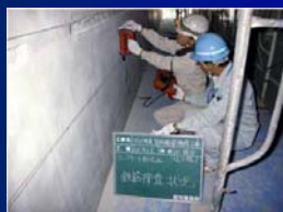
④鉄筋探査工
