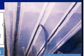
電気防食工法
