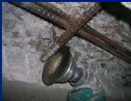
④鉄筋ケレン
