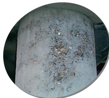
コンクリート中に塩分が入る経路は、水洗いが不十分な海砂をコンクリートの骨材として使用した場合、または、外部から飛来した塩分がコンクリート中に侵入した場合があります。鉄筋周辺のコンクリート中に塩分がある量を超えると、鉄筋の不動態被膜が破壊され錆が発生します。鉄筋は錆びると膨張し、かぶりコンクリートにひび割れ、浮き、剥離等を引き起こします。
