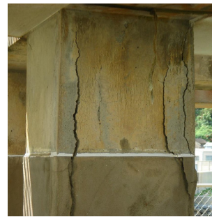
写真 5 柱 A 境界部
