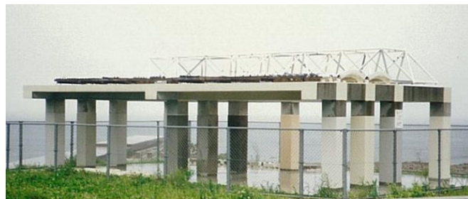
写真 1 実構造物の設置状況
