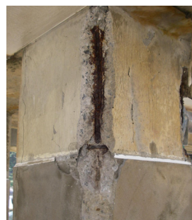
写真 4 柱 A の鉄筋外観
