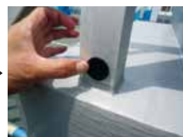
ステムカバー設置
