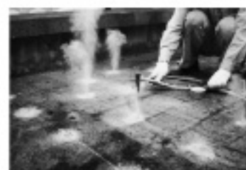
孔内部のモリ粉の除去作業
