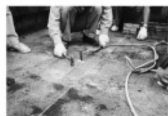
足踏機を使用したバンドEMAグラウト注入作業
