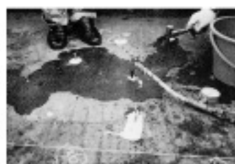
木栓による留止中のEMAグラウト注入作業
