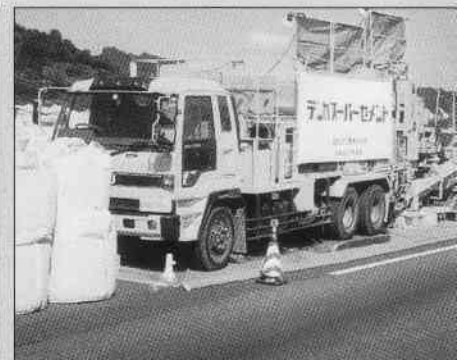
床版上面増厚施工
