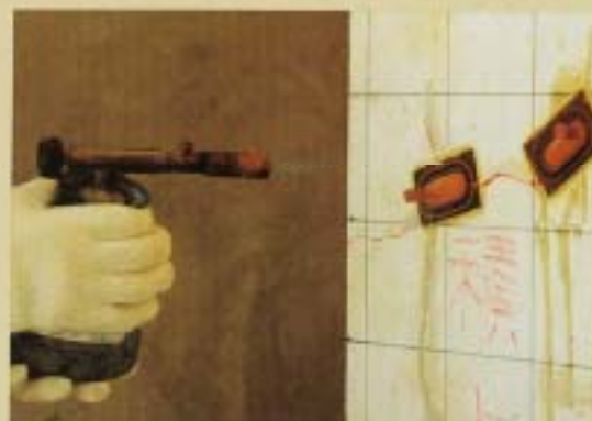
⑩ バーナーによる加熱でプレートの接着剤を除去
