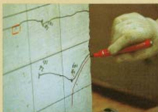
① クラック幅の測定
