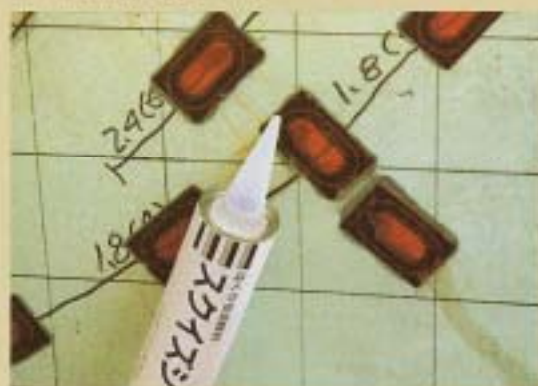
④ クラックのシーリング
