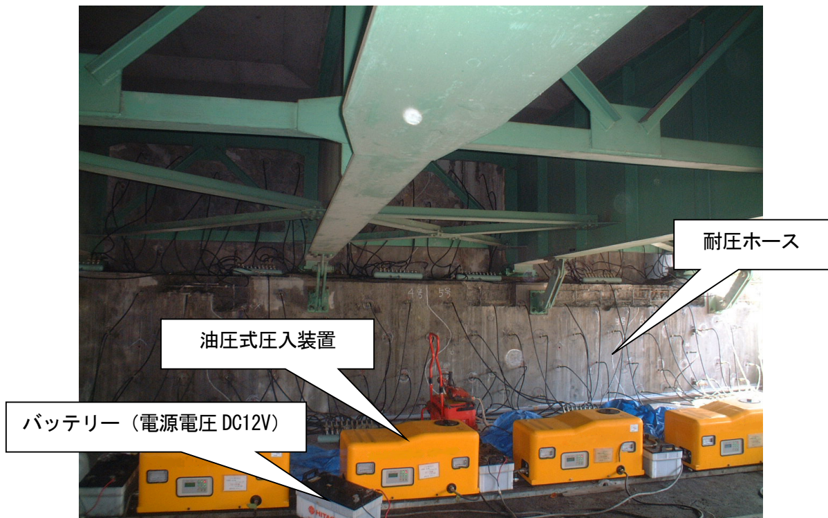
油圧式圧入装置とバッテリーの配置例 (別件)
