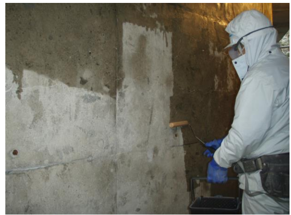
プロコンガードシステム施工状況
