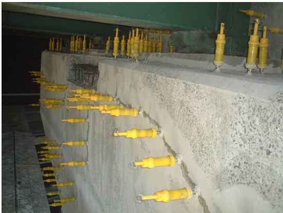
リハビリシリンダー工法施工状況
