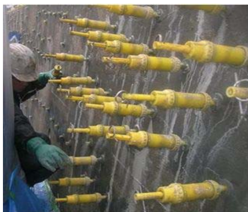
図 4-2 表面漏出防止工(ひび割れ注入工)
