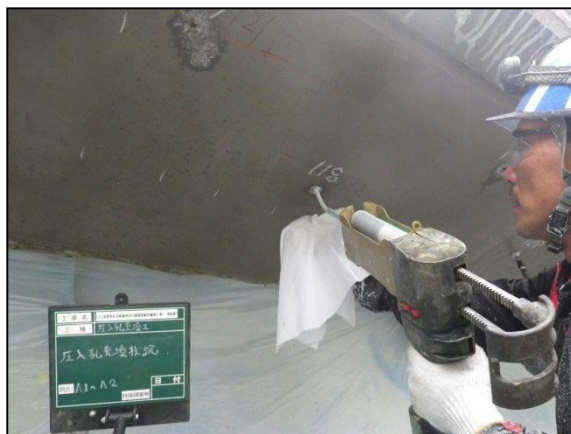
図 4-8 圧入孔充填状況(エポキシ樹脂)
