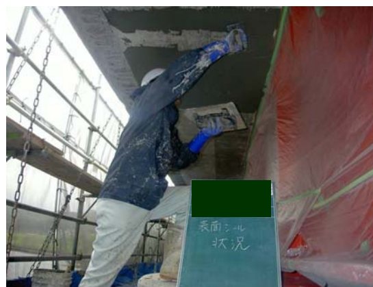
図 4-3 表面漏出防止工(表面シール工)
