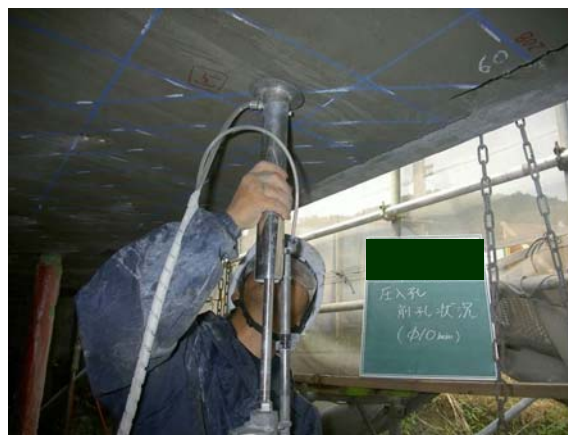
図4-6 削孔状況(ダイヤモンドコアドリル)
