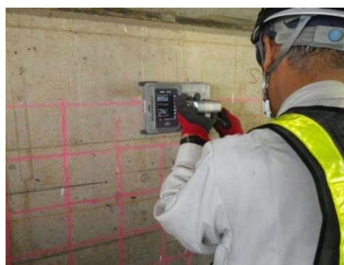
図 4-5 鉄筋探査状況
