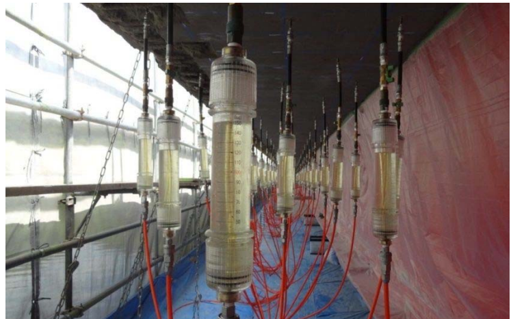
図 1-2 施工状況の例
