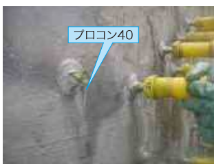
プロコン40先行注入の状況
