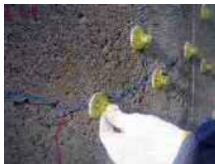
座金設置状況
