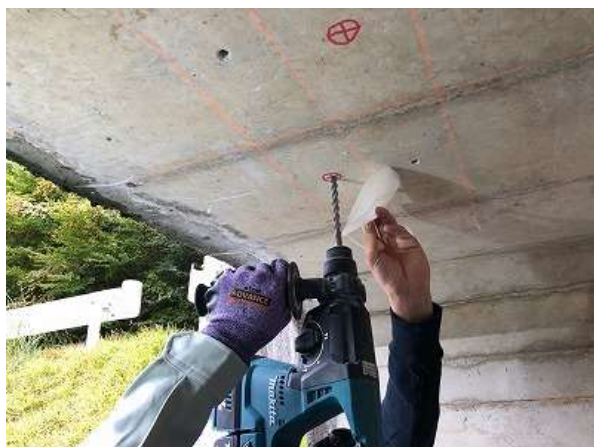
写真-1 ドリル削孔状況
