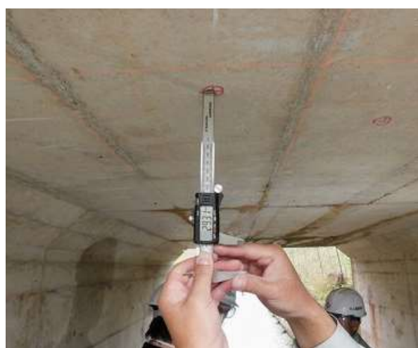
写真-3 中性化深さの測定状況
