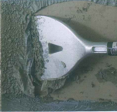
剥離作業状況
