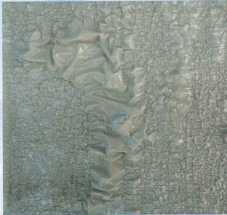
塗布後数時間経過状況
