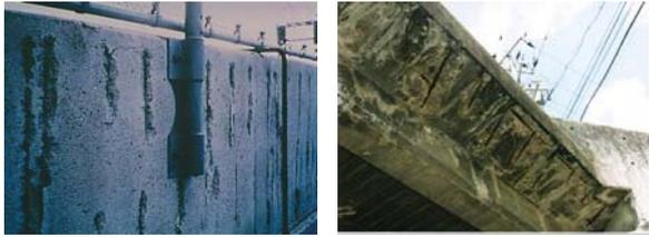
壁高欄のコンクリートはく落      張出し床版下面の鉄筋露出
