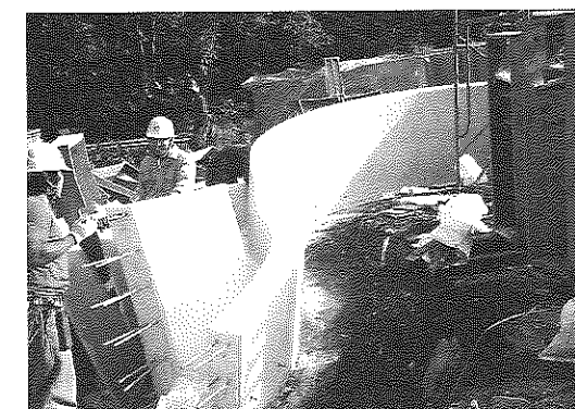
写真5 水路型枠の脱型
