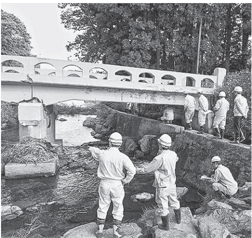
押谷橋を調査する参加者ら
