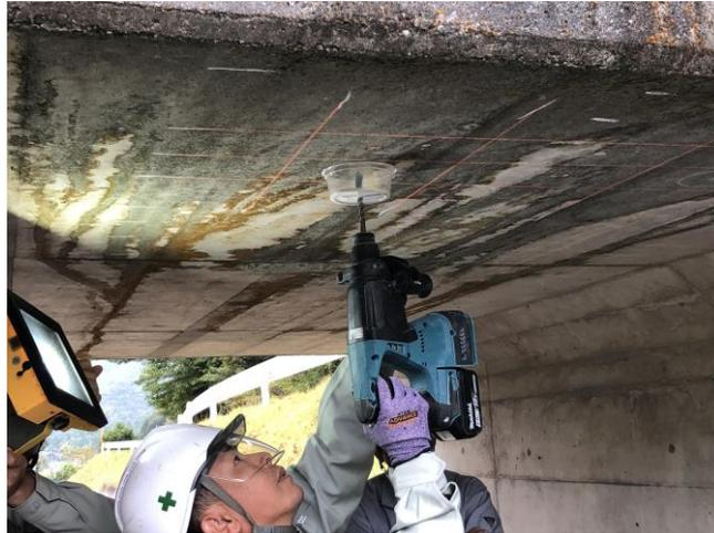
写真-1 試料採取状況（堀田3号線1号橋）
