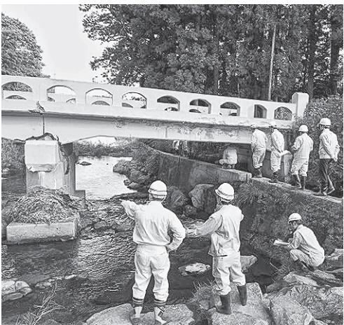
押谷橋を調査する参加者ら
