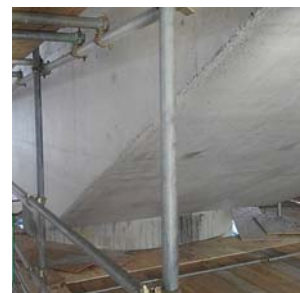
⑩表面仕上げ工
