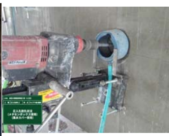
④圧入孔削孔
