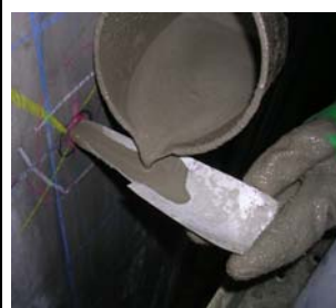
⑨圧入孔充填工
