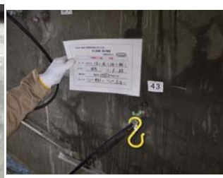
⑧本加圧注入工
