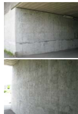
施工後10年経過(2015年)
