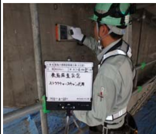
③鉄筋探査工
