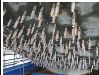
①表面漏出防止(ひび割れ注入)
