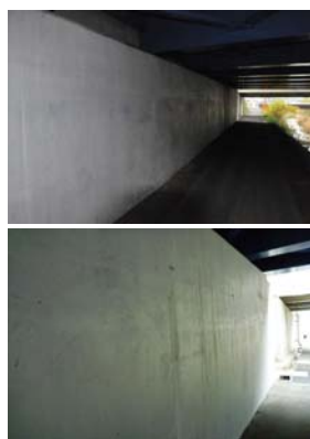
施工後8年経過(2015年) 45
