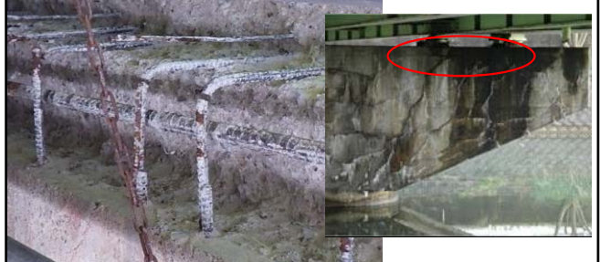
ASRによる鉄筋破断の事例(橋脚はり上縁側鉄筋曲げ加工部)
