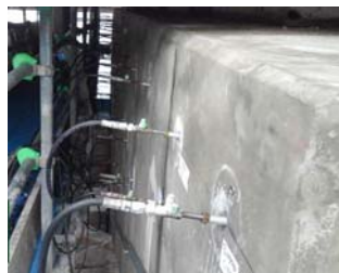
⑦試験加圧注入工
