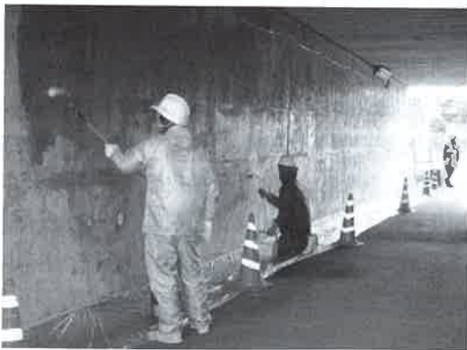
図5 亜硝酸リチウム併用型表面含浸工法の施工状況
