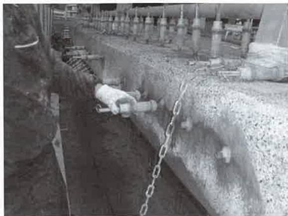
図7 亜硝酸リチウム併用型ひび割れ注入工法の施工状況
