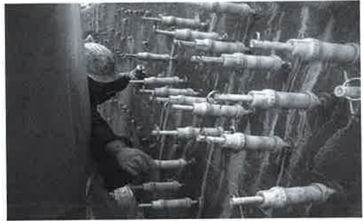
写真4 亜硝酸リチウム併用型ひび割れ注入工法の施工状況
