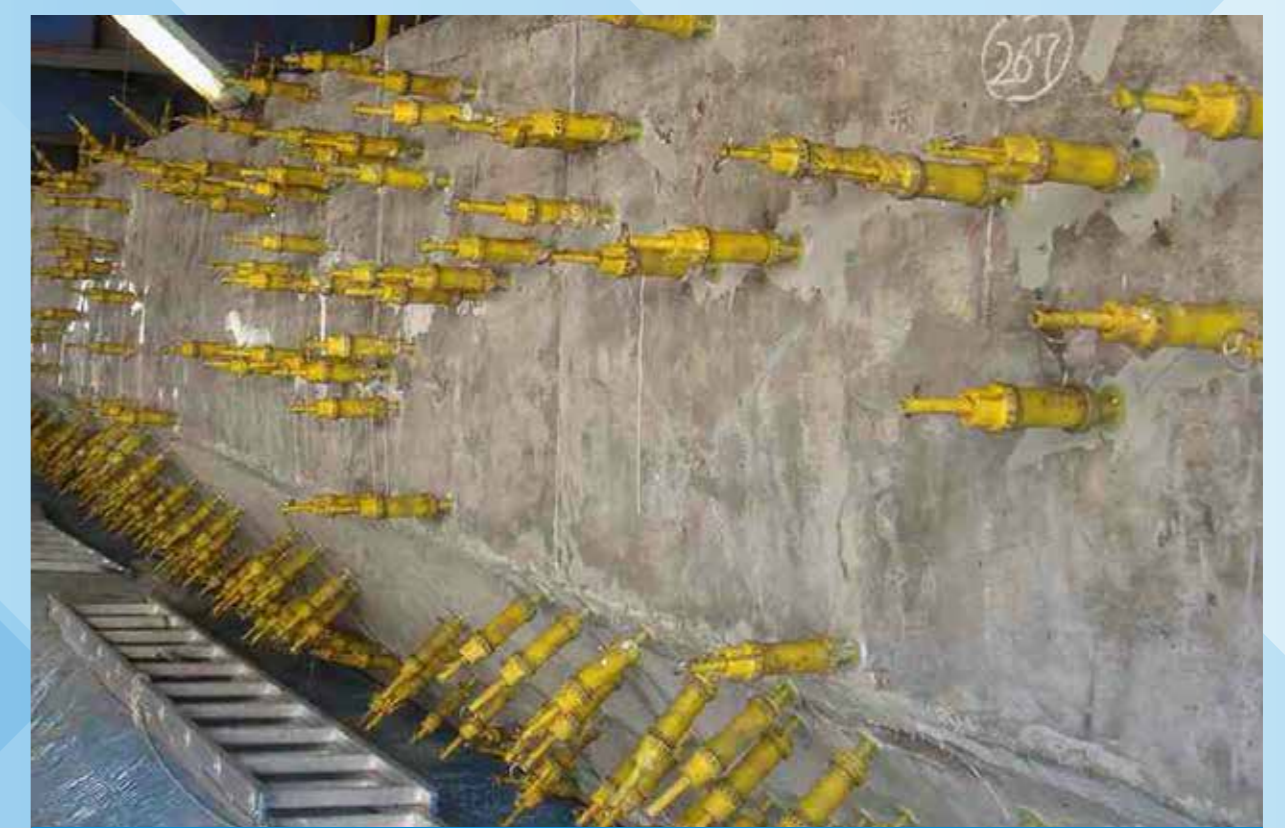
ひび割れ低圧注入『リハビリシリンダー工法』
