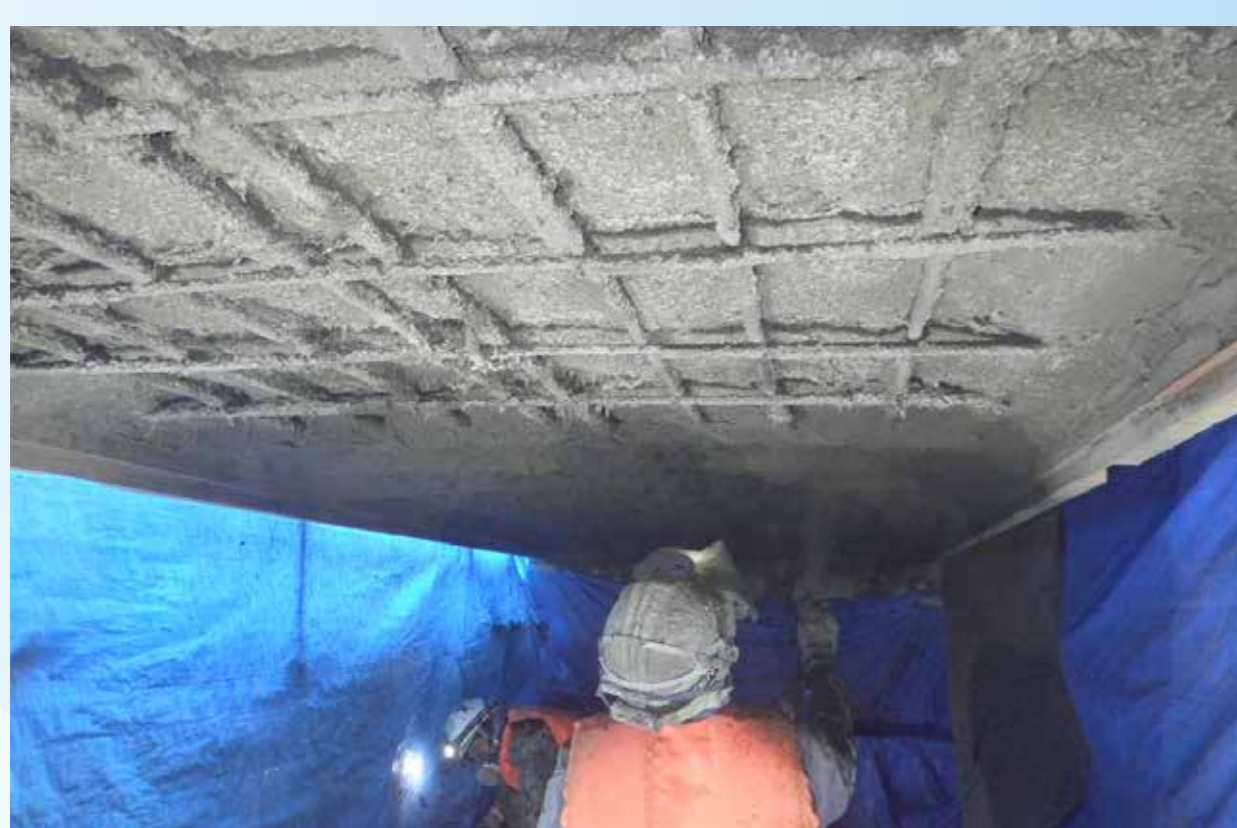
断面修復工法『リハビリ断面修復工法』
