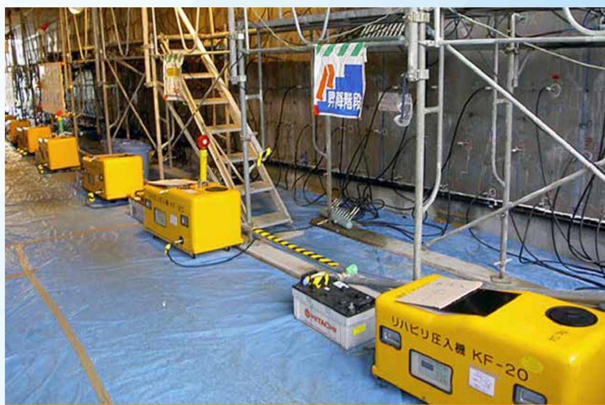
油圧式高圧注入『ASRリチウム工法』
