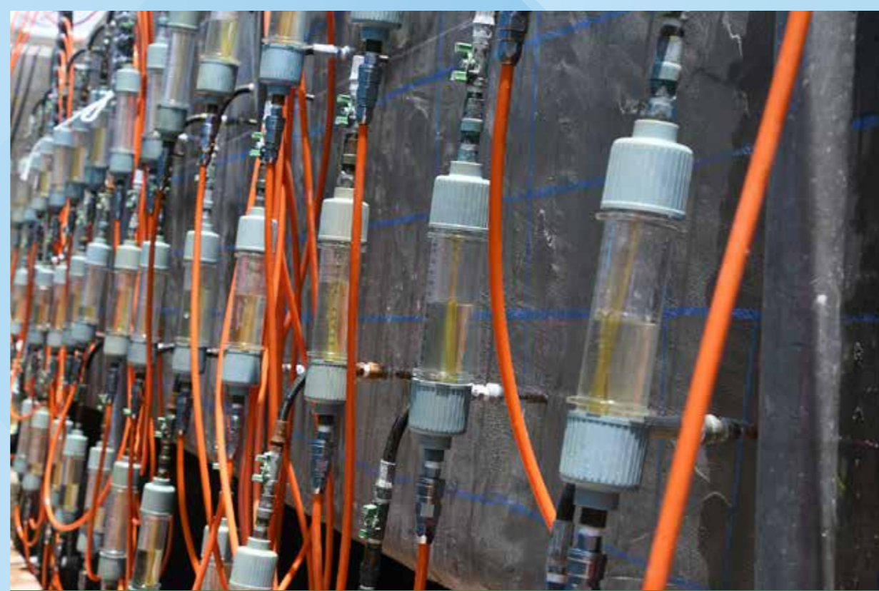
簡易型高圧注入『リハビリカプセル工法』
