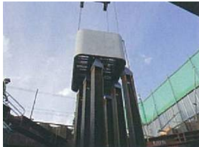
橋梁下部工 橋脚部の埋設型枠
