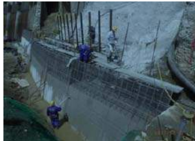
擁壁工 外壁の埋設型枠
