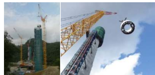
クレーンで吊り込み設置
