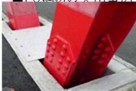
▲破断箇所修復
