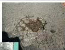
(床版上面) 舗装土砂化
