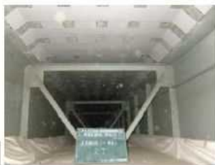
炭素繊維シートの貼り付け
