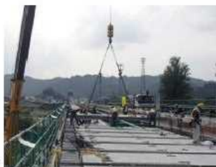
プレキャスト床版による 打ち替え
