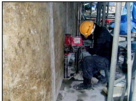
主鉄筋用アンカー削孔
