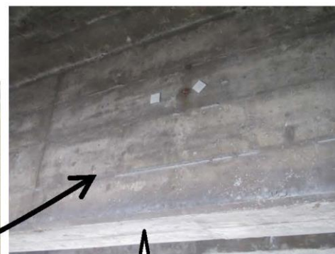
桁内2枚 (桁面は海側)
