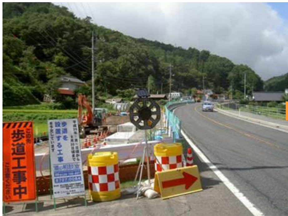
施工中（車道共用）
