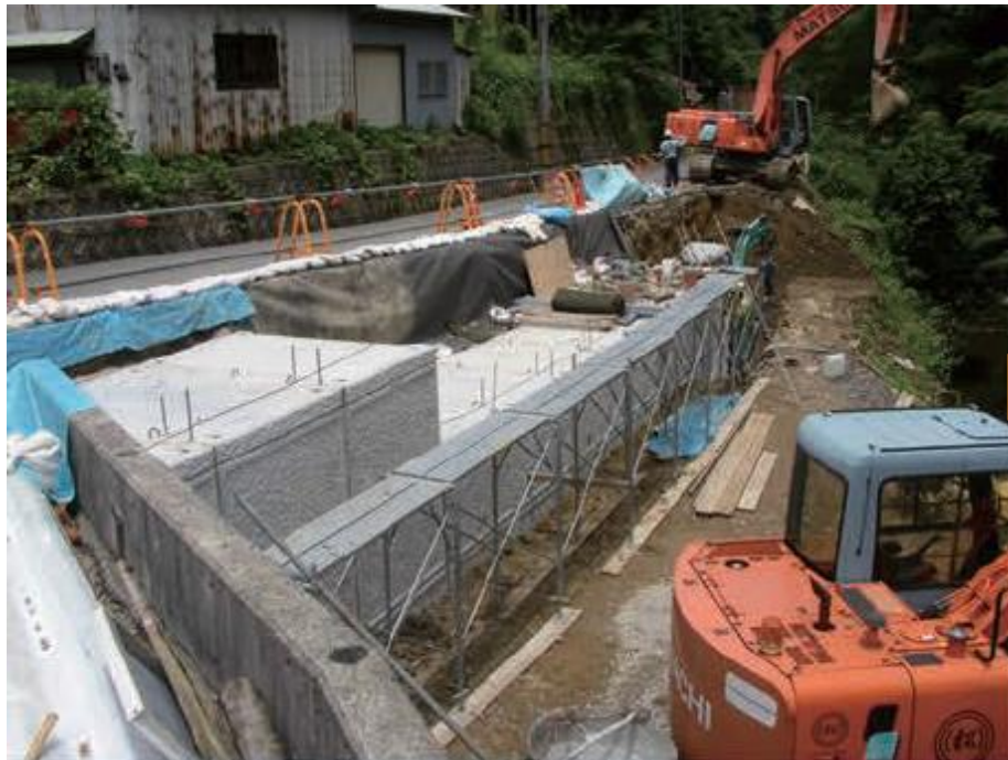
施工中（通路確保）
