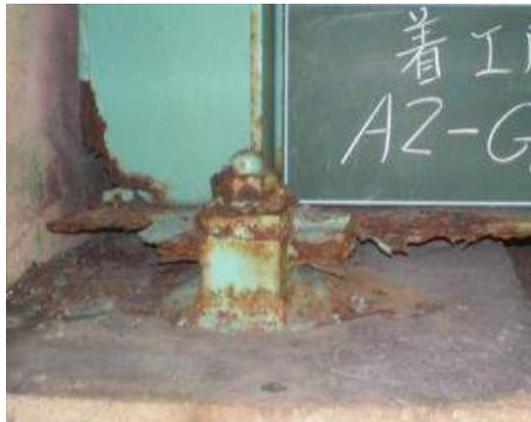
塩害による桁端部の腐食、
