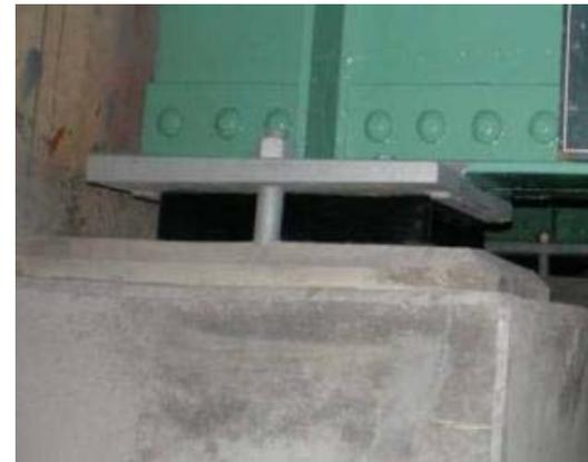
桁端部の当て板補強・塗装、
