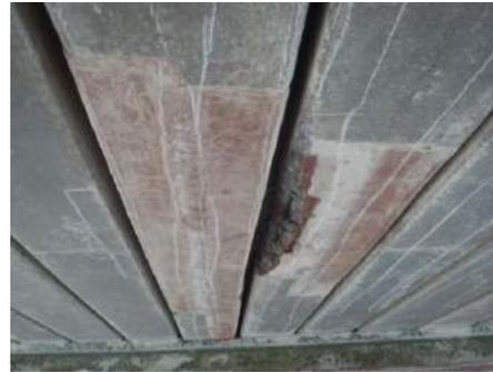
断面補修箇所(茶色)の再劣化
