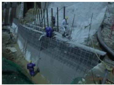
擁壁工 外壁の埋設型枠
