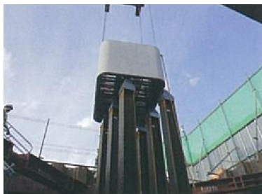
橋梁下部工 橋脚部の埋設型枠
