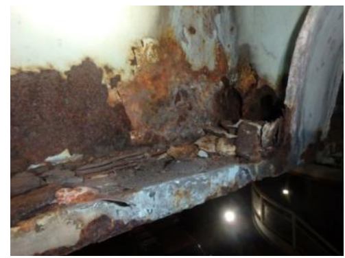
鋼材の腐食状況
