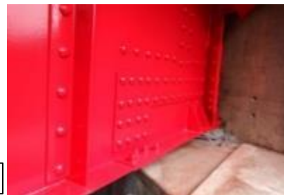
桁端部の当て板・塗装
