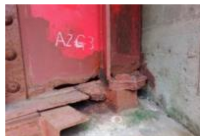
桁端部の腐食・貫通
