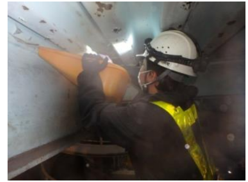
腐食片撤去状況
