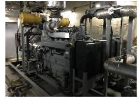
＜自家発電装置＞
