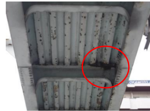
腐食片落下想定箇所
