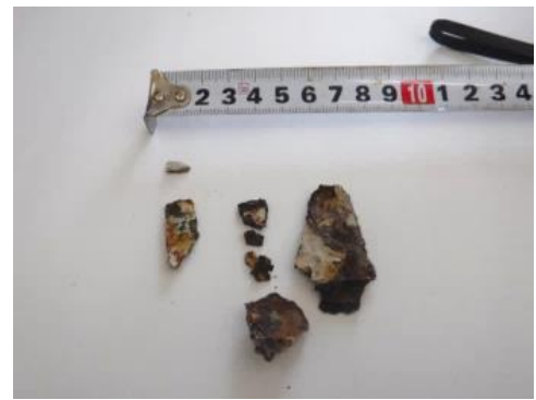
落下した腐食片
