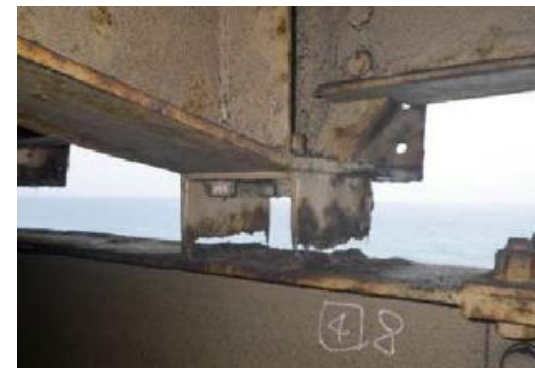
▲シールド頂部の主梁端部 (破断の例)
