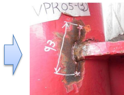
塗膜撤去・詳細調査後
