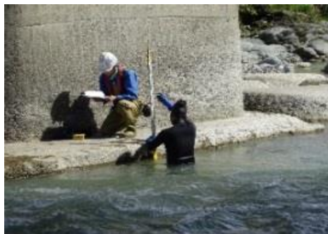
▲潜水土による洗掘調査
