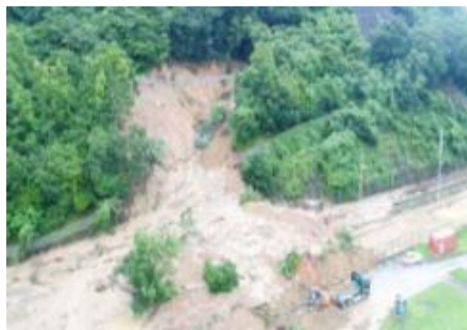
広島県道路・JR呉線の被災状況 (平成30年7月豪雨)
