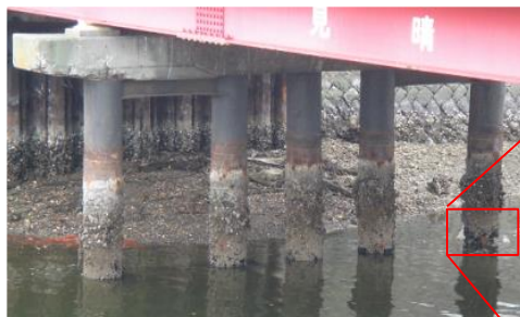
▲杭の水中部 (腐食・断面欠損の例)
