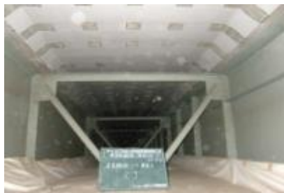
炭素繊維シートの貼り付け
