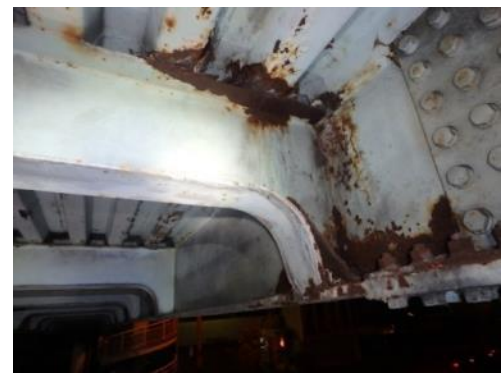
鋼材の腐食状況
