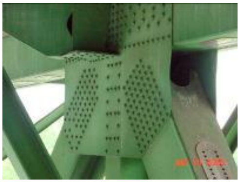
板厚不足とされたガセット
