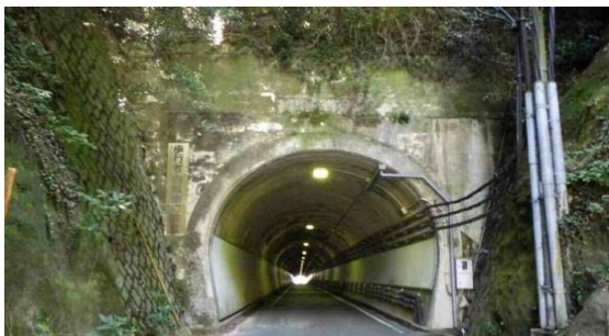
<仁方隧道の状況>
