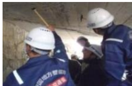
登岐平橋の点検支援 (熊野町) H30.2.8
