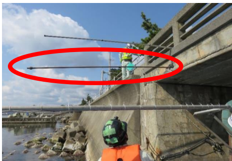
▲PC鋼材の突出事例
