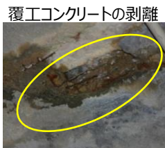
覆工コンクリートの剥離
