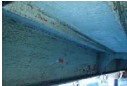
桁の塗装劣化やさびの発生
