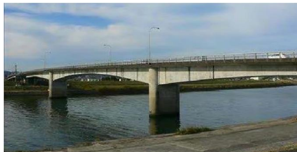
<天大橋の状況>
