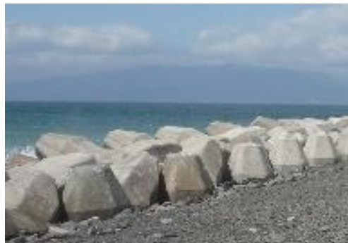
<消波・根固ブロック>
