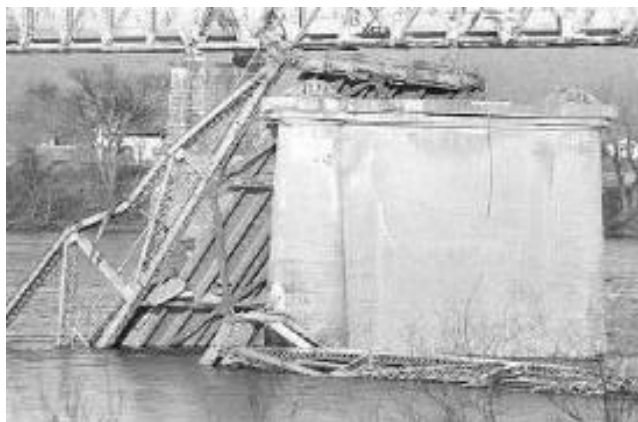
ケーブルの疲労（破壊）により落橋 (1967年12月)
