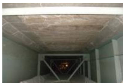
ひび割れの発生
