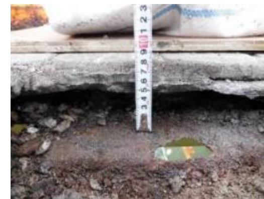
■ 橋面舗装の状況
