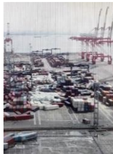
神戸港六甲アイランド の被災状況 (台風第21号)
