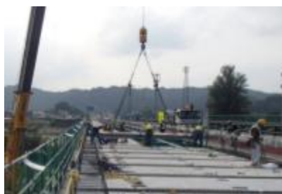
プレキャスト床版による 打ち替え
