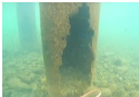
▲パイルベントの断面欠損
