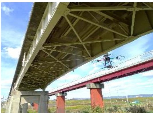
▲橋梁の損傷写真を撮影する技術
