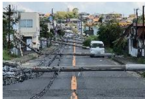
<電柱倒壊による道路閉塞>
