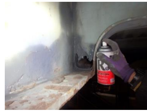
腐食片除去後の防錆作業
