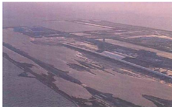
関西国際空港の被災状況 (台風第21号)
