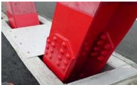
▲破断箇所の修復
