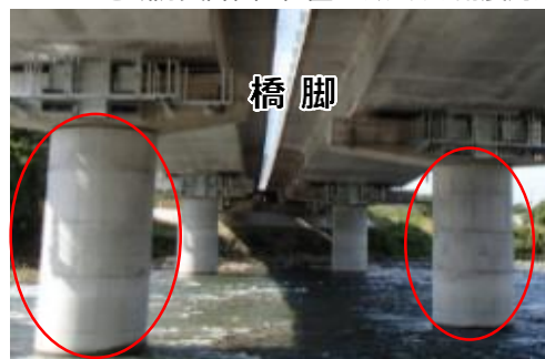
<橋梁の耐震対策>
