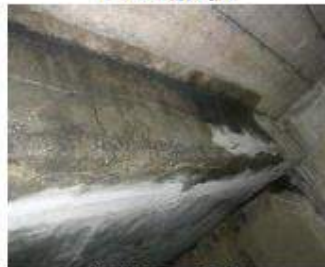
▲桁端部の漏水
