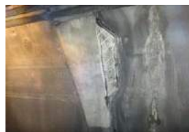
▲トンネル目地部
