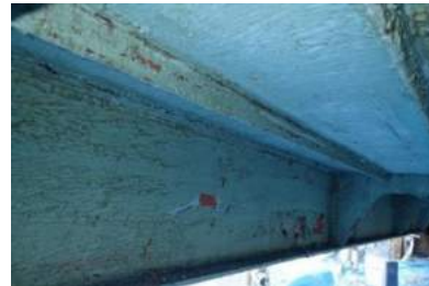
桁の塗装劣化やさびの発生
