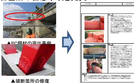
▲PC鋼材の突出事例
