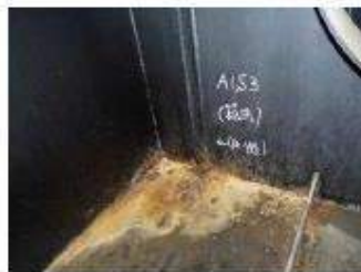
▲桁端部の堆砂
