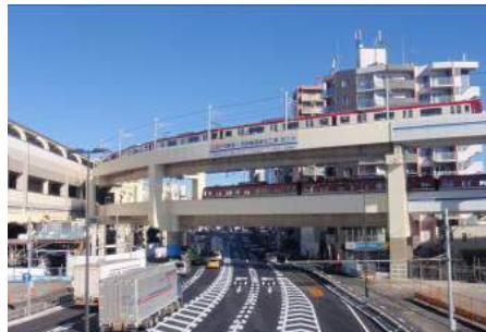
<連続立体交差事業>
