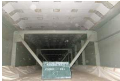
炭素繊維シートの貼り付け
