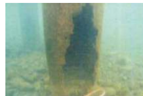
▲橋脚水中部の断面欠損
