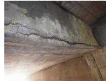
▲桁端部のひび割れ、うき
