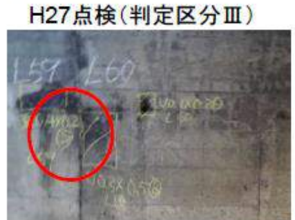
▲目地沿いに発生したうき
