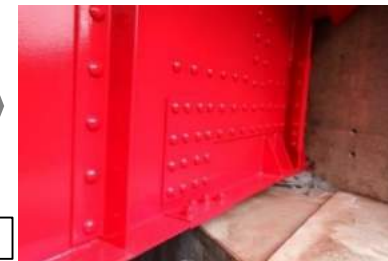
桁端部の当て板・塗装
