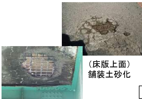
(床版下面) 床版の抜け落ち
