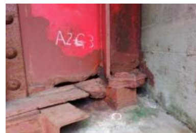
桁端部の腐食・貫通
