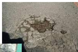
(床版上面) 舗装土砂化
