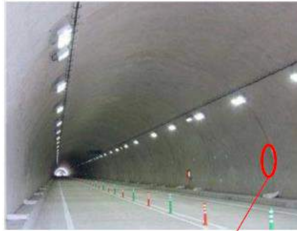
近接目視により確認された「うき」
