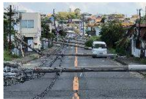
＜電柱倒壊による道路閉塞＞
