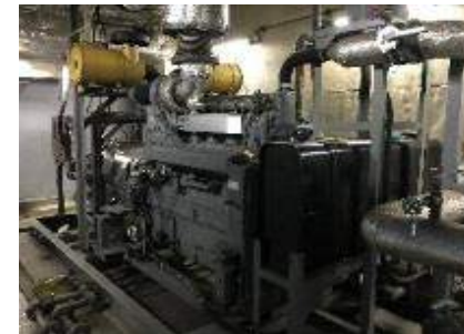
<自家発電装置>
