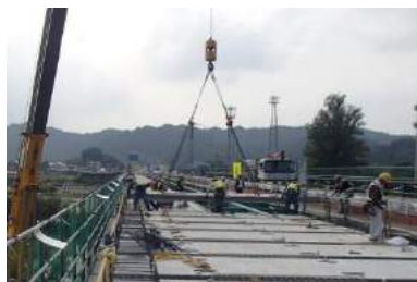
プレキャスト床版による 打ち替え
