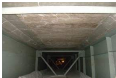
ひび割れの発生
