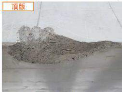
剥離・鉄筋露出（供用後3年）
