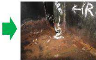
▲桁端部の腐食、断面欠損
