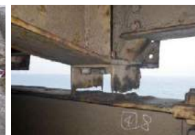
▲シェッド主梁端部破断
