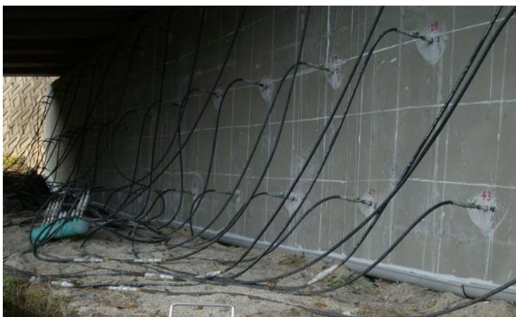
【施工例】 H25年 国土交通省中国地方整備局「柳川橋」
