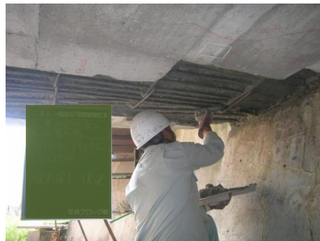
剥離部を部分断面修復
