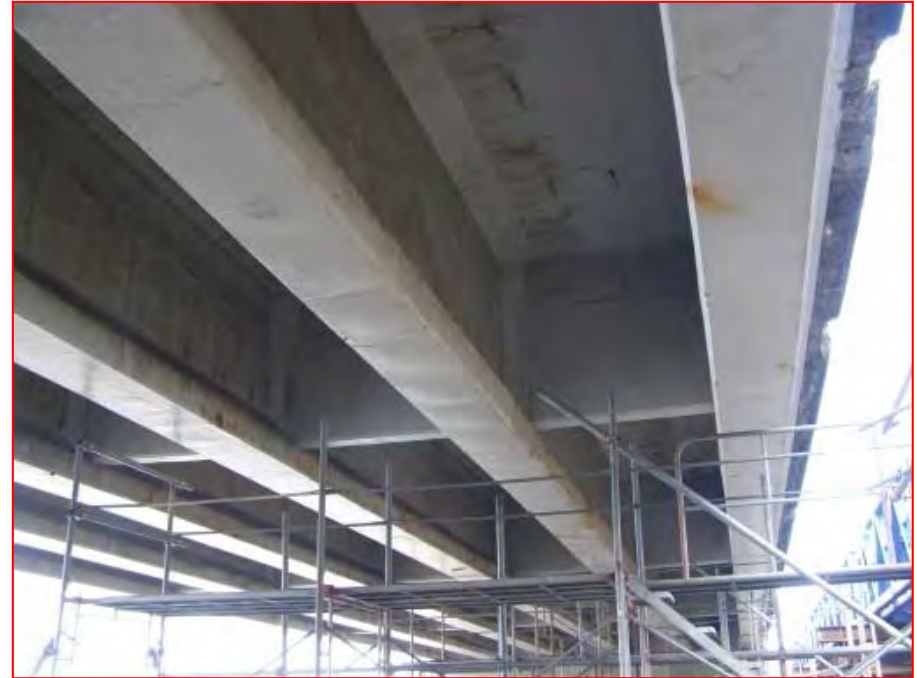
第3径間（劣化が小さい）
