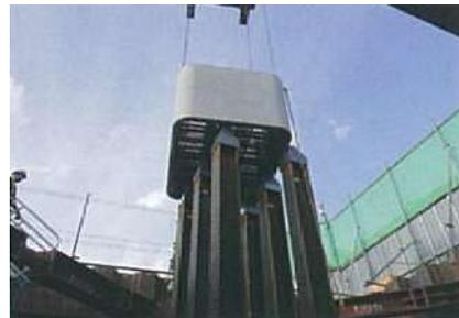
橋梁下部工 橋脚部の埋設型枠
