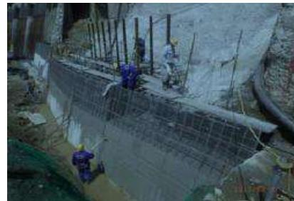
擁壁工 外壁の埋設型枠
