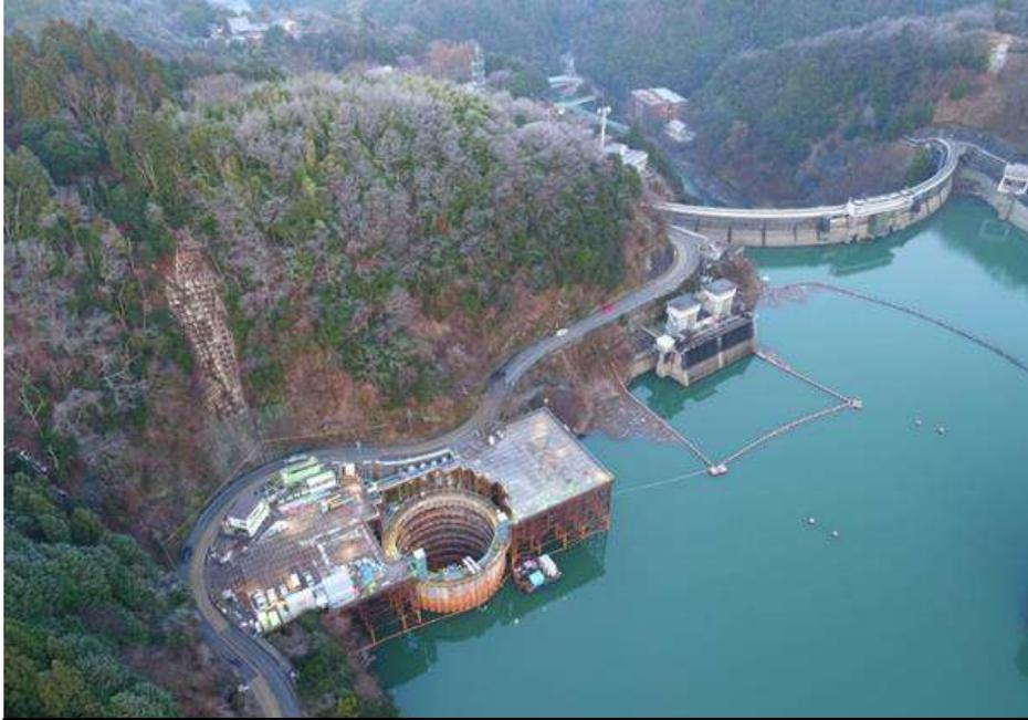
トンネル式放流設備流入部(高さ 50.3 mのうち 39.8 m)
