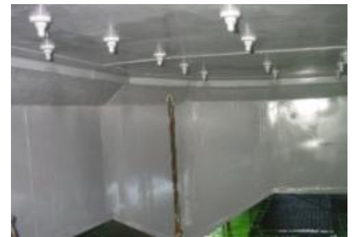
天井部 GFプロテクト施工
