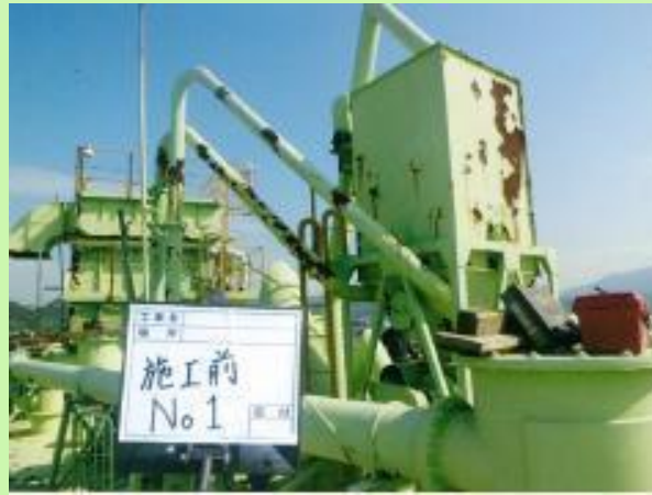
セメントサイロ 施工前
