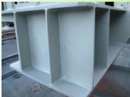
下塗材塗布状況
