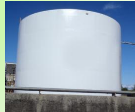
化学工場 施工後
