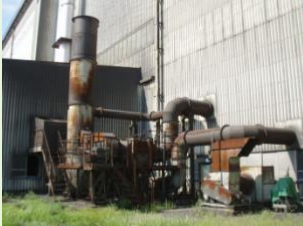
屋外排気設備 施工前
