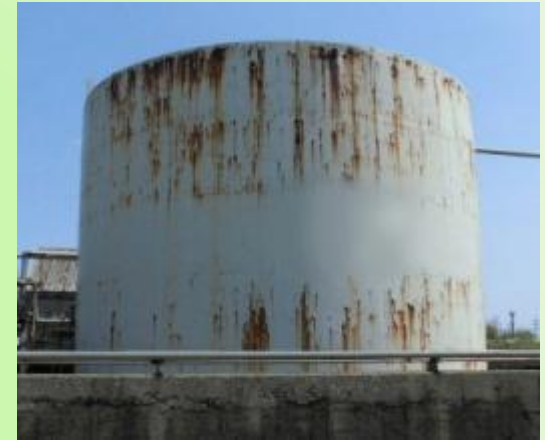
化学工場 施工前
