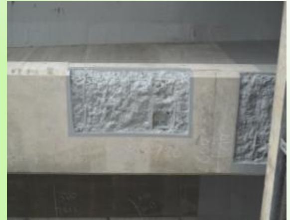
補修箇所拡大
