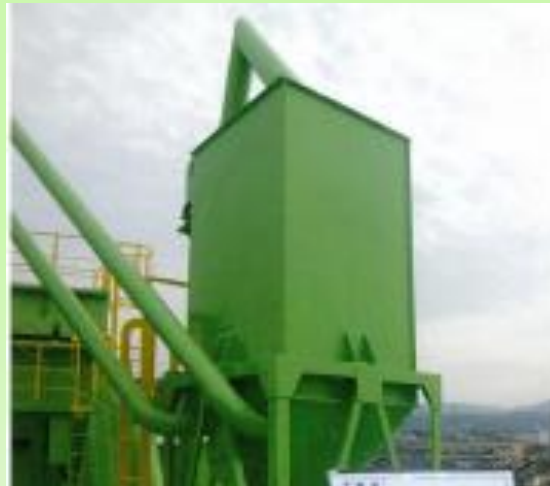
セメントサイロ 施工後
