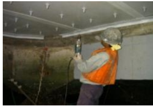
端部アングル取付
