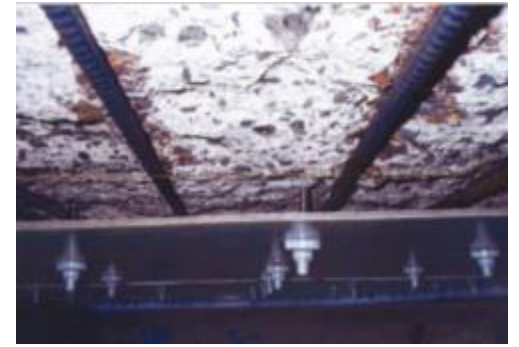
埋込型枠加工取付(GMP板=7mm)
