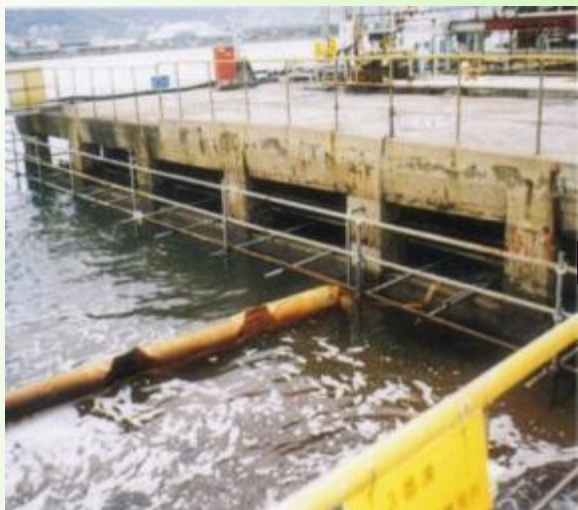
施工前(全体像)
