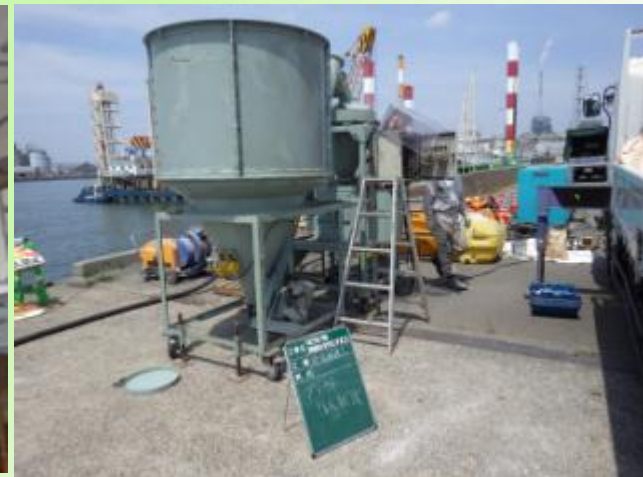
グラウト注入
