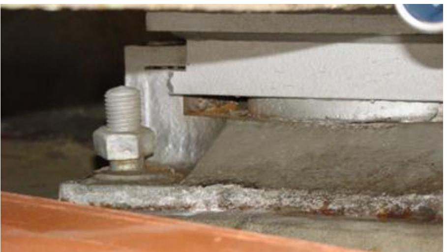
支承のアンカーボルトや取り付けボルトのゆるみ
