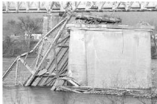
ケーブルの疲労（破壊）により落橋
