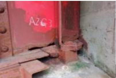
桁端部の腐食・貫通
