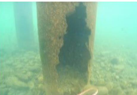
▲パイルベントの断面欠損
